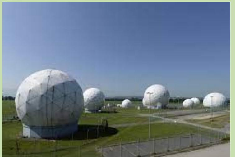
**Radôme** Pour les antennes stationnaires, une accumulation de glace excessive peut changer ses caractéristiques, par changement d'impédance, réduisant la puissance d'émission.
