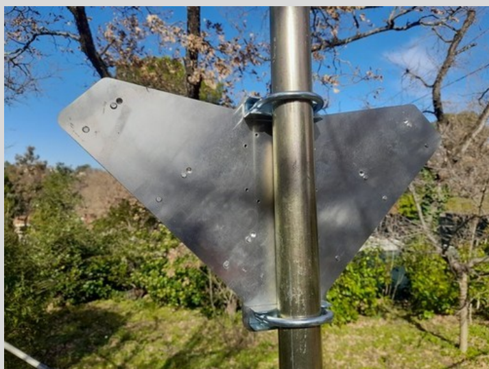
Fixation de la plaque avec les "U"
