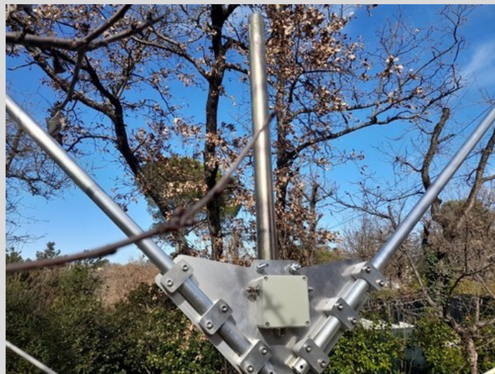
Pose des 2 brins d'antenne
