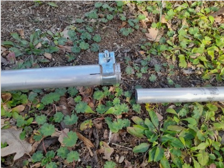
Assemblage des tubes avec des colliers
