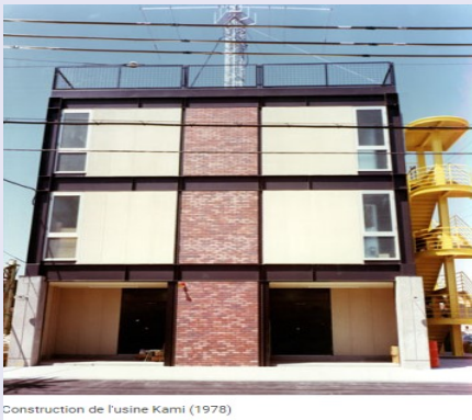
Construction de l'usine Kami (1978)
