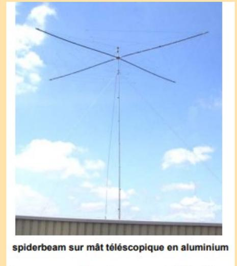
spiderbeam sur mât télescopique en aluminium
