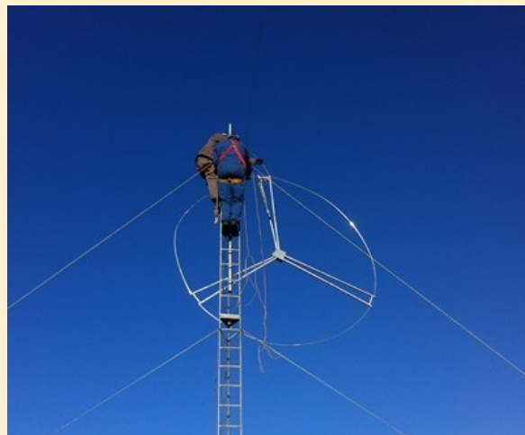
Montage de l'antenne BIGWHEEL
