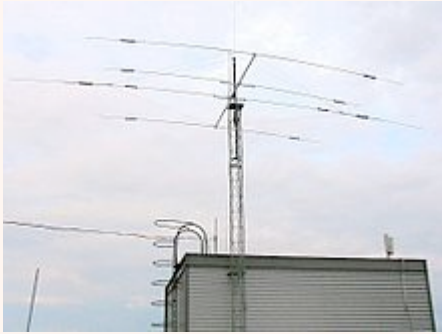
Une antenne multibandes HF de type Yagi rotative
