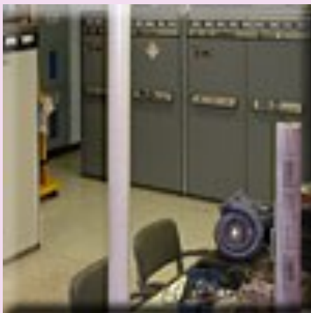
Émetteurs de gauche à droite: primaire 5,0 MHz (10 kW), veille 5,0 MHz (5 kW) et veille 15,0 MHz (5 kW)
