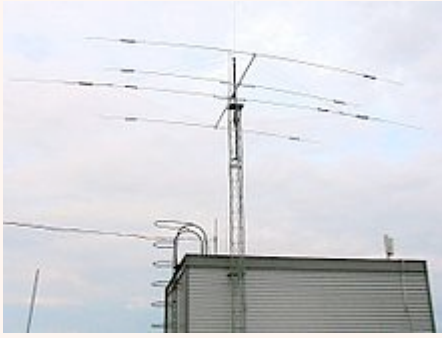
Une antenne de type Yagi HF
